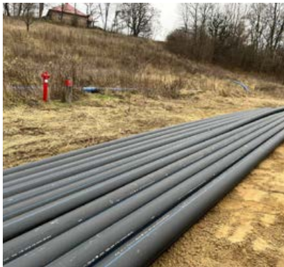
Budowa sieci wodociągowej w Niżnej Łące
