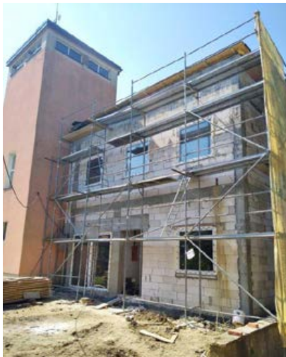
Budowa budynku wielofunkcyjnego w Rogach
