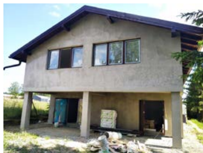
Budowa budynku wielofunkcyjnego w Miejscu Piastowym
