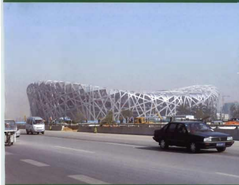
Stadion olimpijski (w budowie), na którym odbędzie się otwarcie olimpiady.
